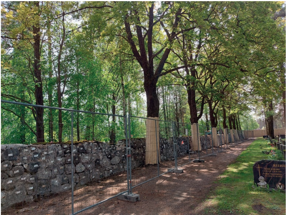
Ristikankaan muurin jokainen kivi merkittiin numerolla ennen muurin purkua ja muurattiin uudelleen oikealle paikalleen. Kuva: Seija Kuosmanen.
