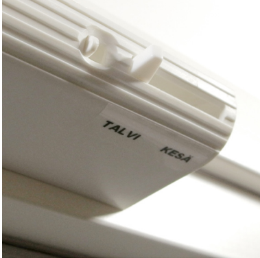
Sisäyksikön irrotusvipu ja manuaalinen kesä/talviasennon säädin sijaitsevat vierekkäin.
