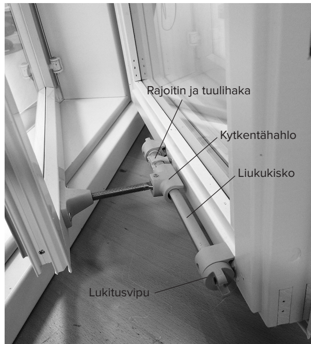
Liukukiskon lukitusvipu pystyasennossa (kytkettynä).
