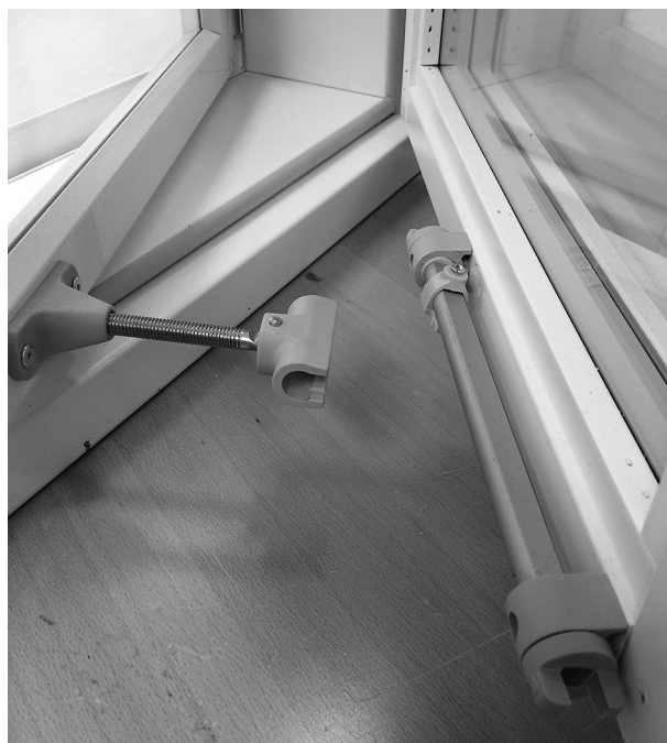
Liukukiskon lukitusvipu vaaka-asennossa (vapautettuna).
